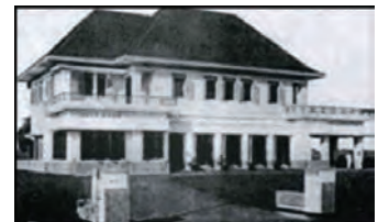
Sumber : www.jakarta.go.id Gamba 5.5 Gedung Penyusunan Naskah Proklamasi Kemerdekaan, Jalan Imam Bonjol No.1 Jakarta
