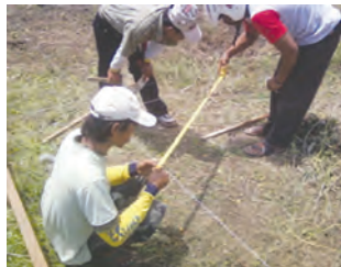
Gambar 5.1 Seorang Tukang sedang mengukur kesikuan lahan
